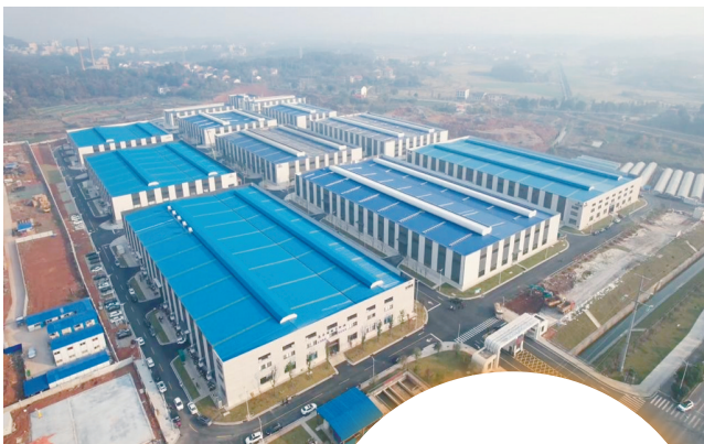
▲建设中的泵业产业园。
