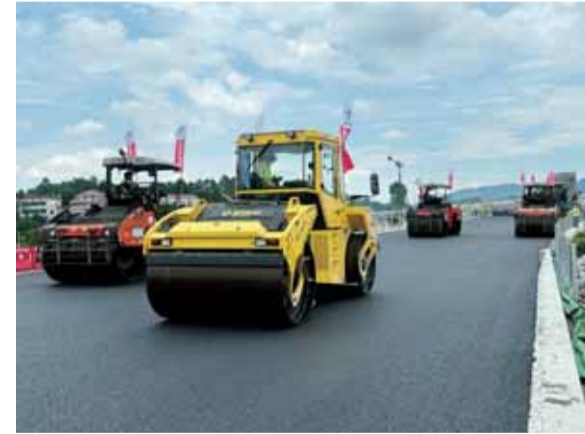
白南高速公路施工现场。
