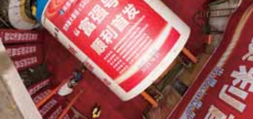
“富强号”顶管掘进机在现场人员的注视下徐徐推进。 ■彭 斌 摄
