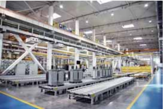
湖南电气新型高端配电数字化工厂调试设备。 ■周 围 摄
