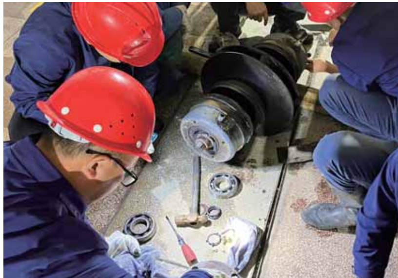
工作人员对供水设施进行维修。
