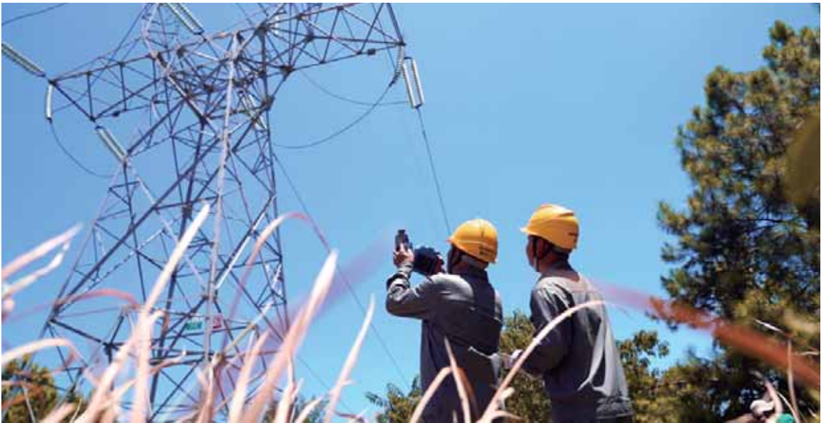
对变电设备开展检修消缺。 ■陈明 摄
