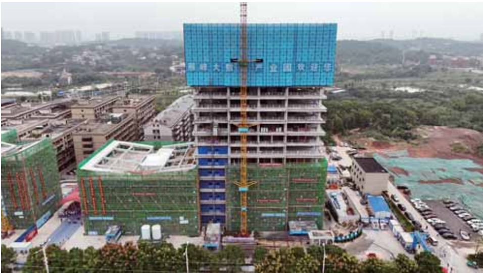
正在建设中的衡阳算力中心。
