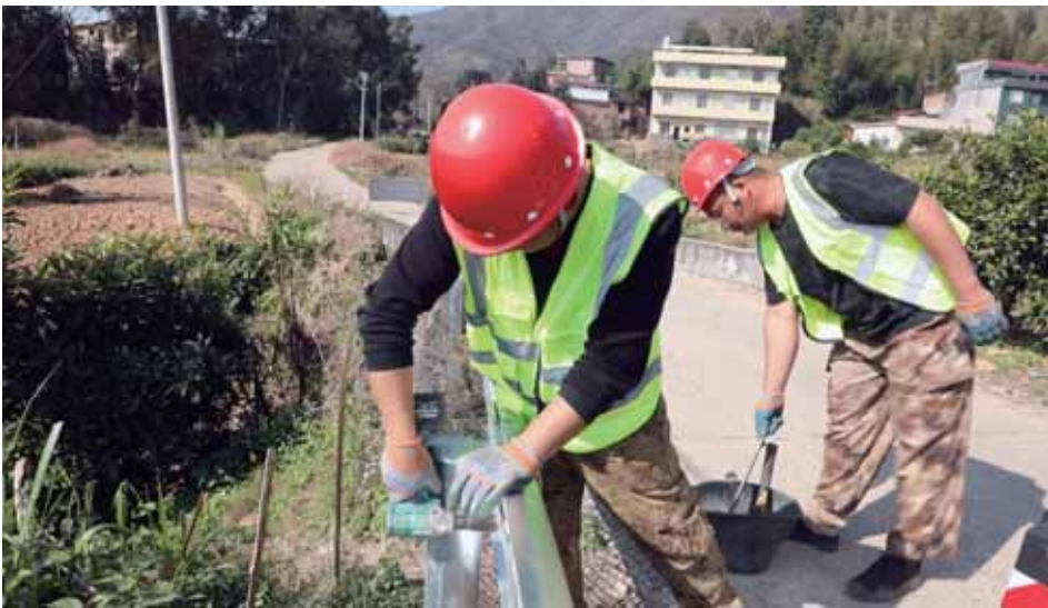
工人们正在安装防护栏。
