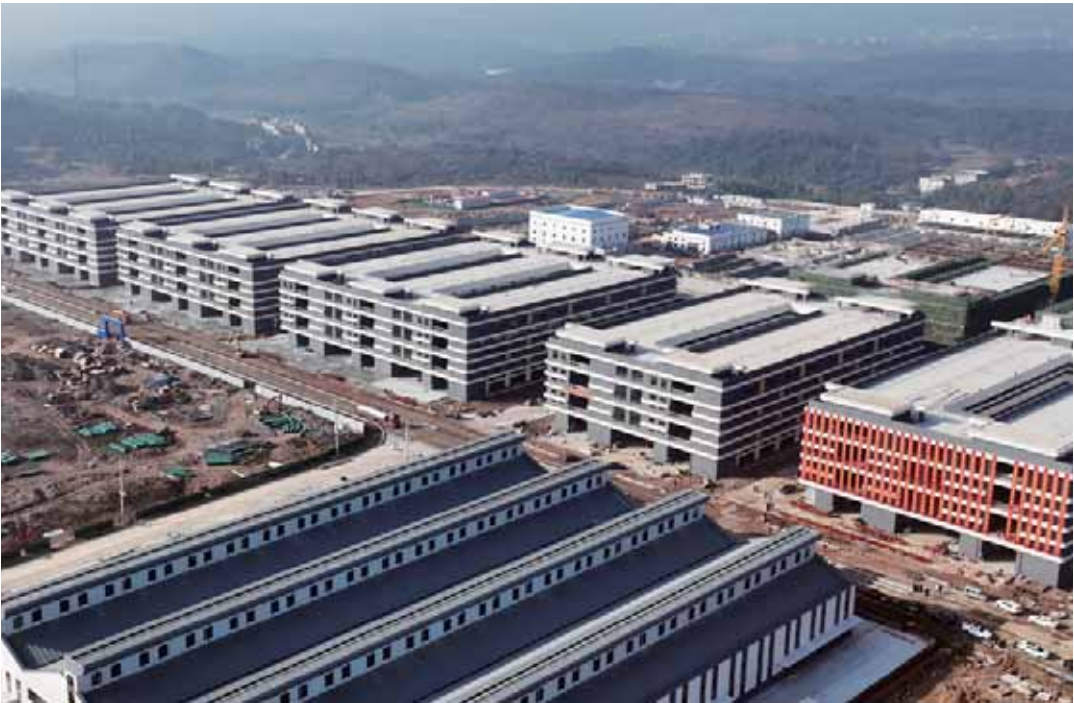
正在火热建设中的环保设施园。
