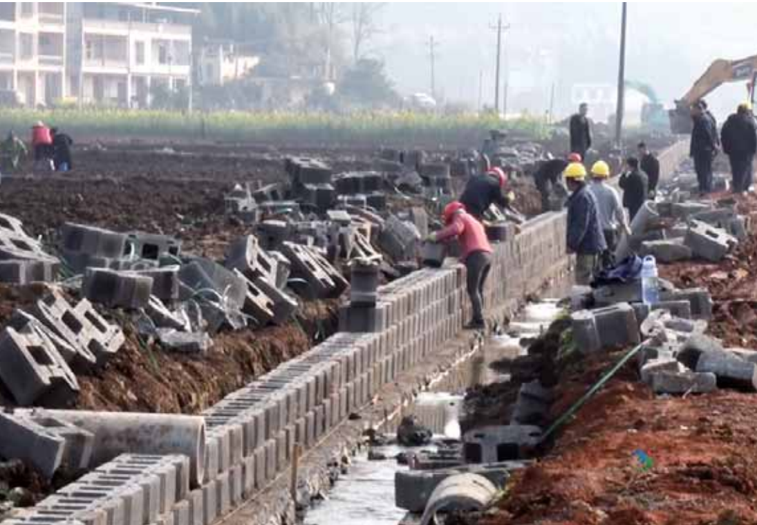
常宁市高标准农田建设施工现场。
