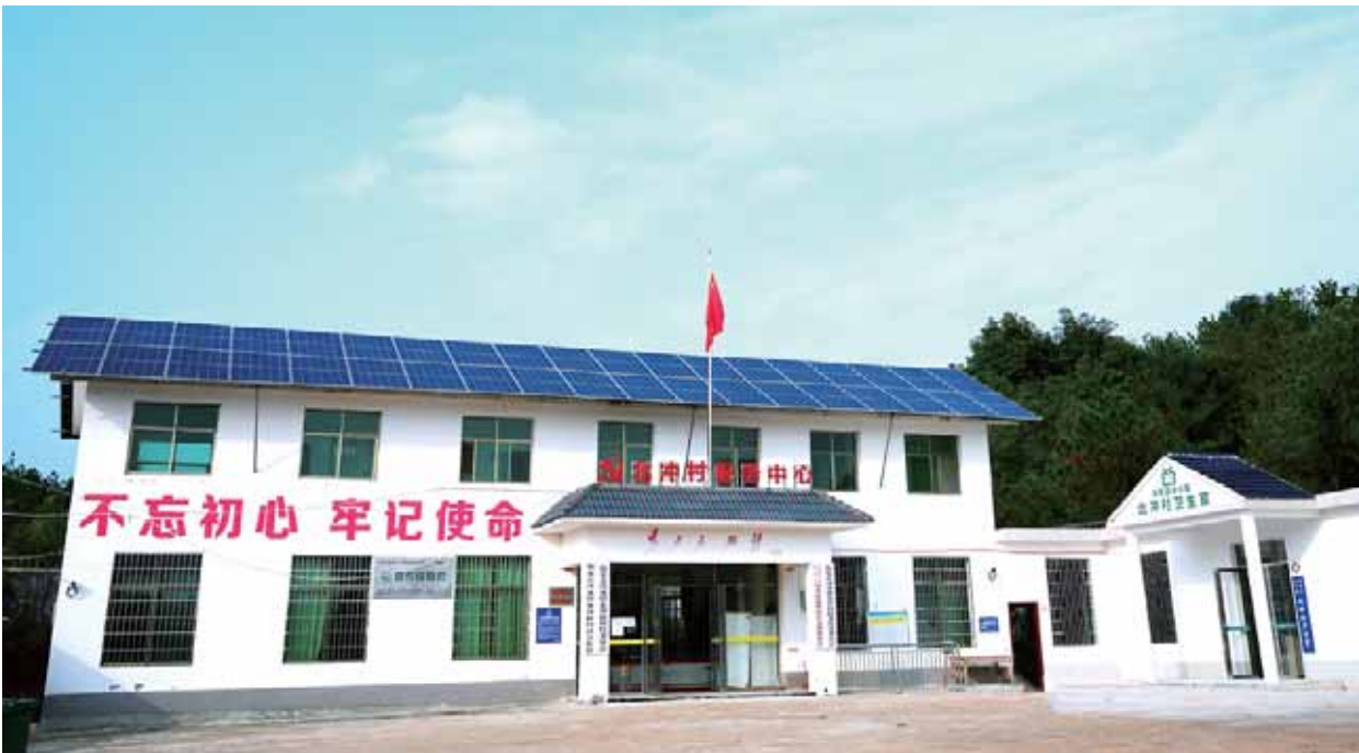
建在村部的屋顶光伏电站，全年可发电约4.5万千瓦时。
