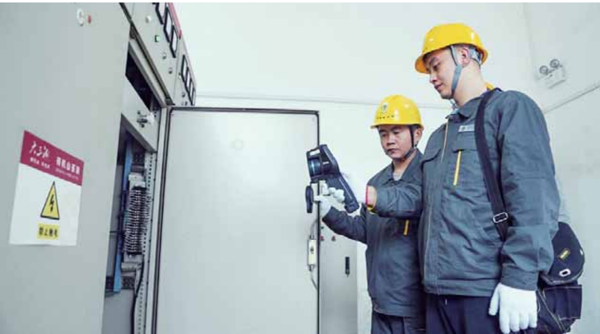
工作人员检测配电设备。
