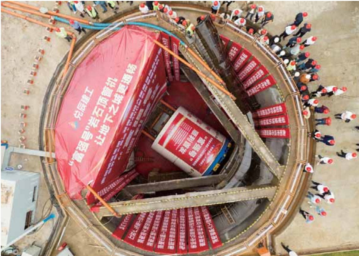
10月27日,长江经济带衡阳市虎形山片区绿色发展建设项目“富强号”顶管掘进机正式始发。■彭斌 摄
