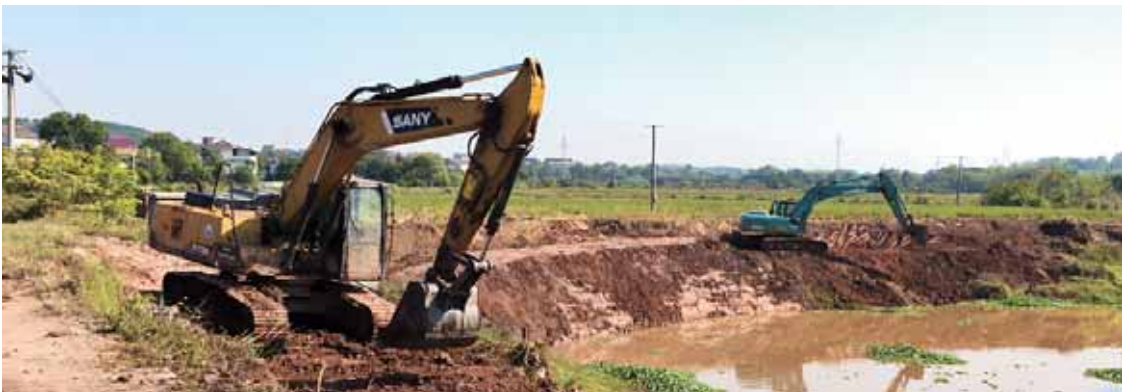
图为挖机正在进行疏浚作业。
