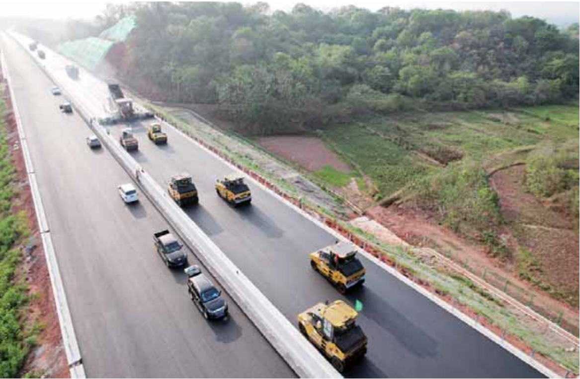
衡永高速公路路面二标段施工现场。
