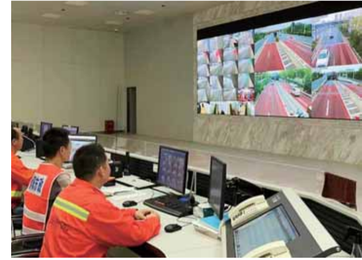
假期加强值班值守，工作人员密切关注隧道内车流通行情况。
