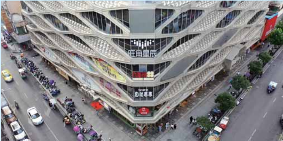
针对旺角星辰商业综合体消防火灾隐患，石鼓区委、区政府高度重视、密集调度，历经6个月整治，完成该高层建筑消防火灾隐患整改。
