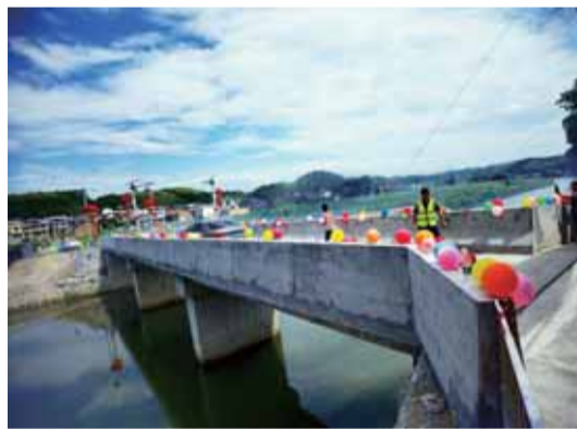
在衡阳市委巡察组的推动下，耒阳市三都镇早禾田村的“漫水桥”得到新建。
