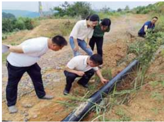
2023年5月，祁东县委第一巡察组在黄土铺镇上新村大坝冲右干渠滴灌延伸项目施工现场巡察督导。
