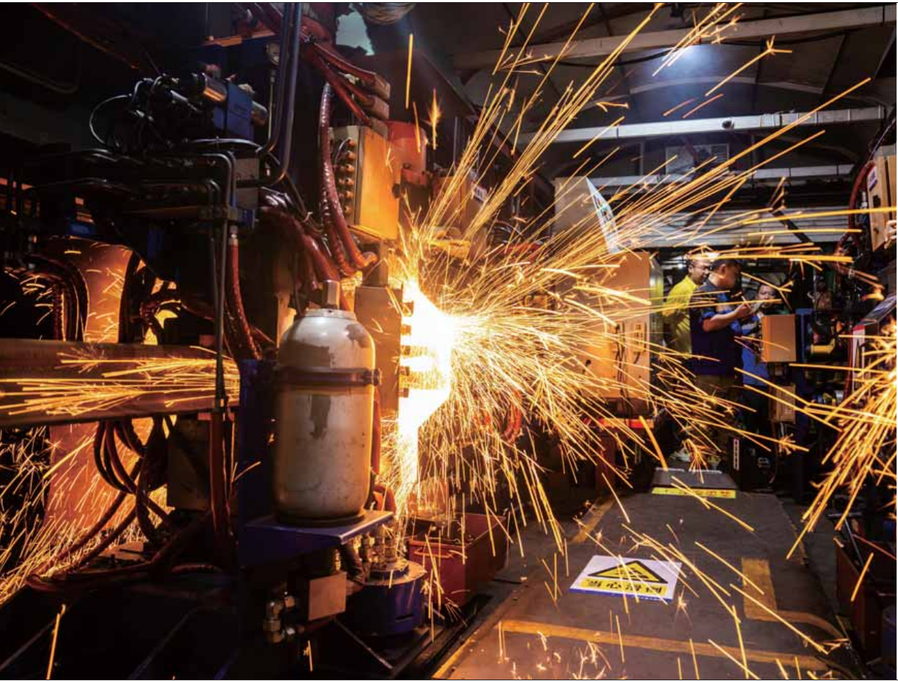
9月6日凌晨，在京广高铁株洲西至衡山西区间，铁路工人操作车载焊机进行焊轨作业。 当日，在京广高铁株洲西至衡山西区间，广铁集团广州工务大修段工人在不影响线路运行的情况下，开始对京广高铁钢轨进行换轨施工。据了解，此次施工共需更换钢轨 29 公里，施工工期约 50 天，采用高铁一体化换轨施工工艺，做到“工完料清、人走场清”，确保列车行车安全。 ■新华社发
