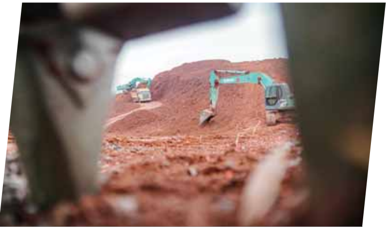
繁忙的施工现场。
