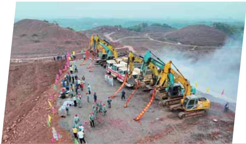
换流站“四通一平”正式开工。
