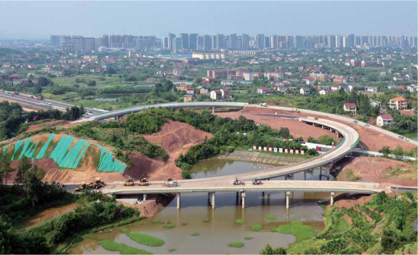
衡永高速公路项目蒸湘段寺塘冲枢纽互通。
