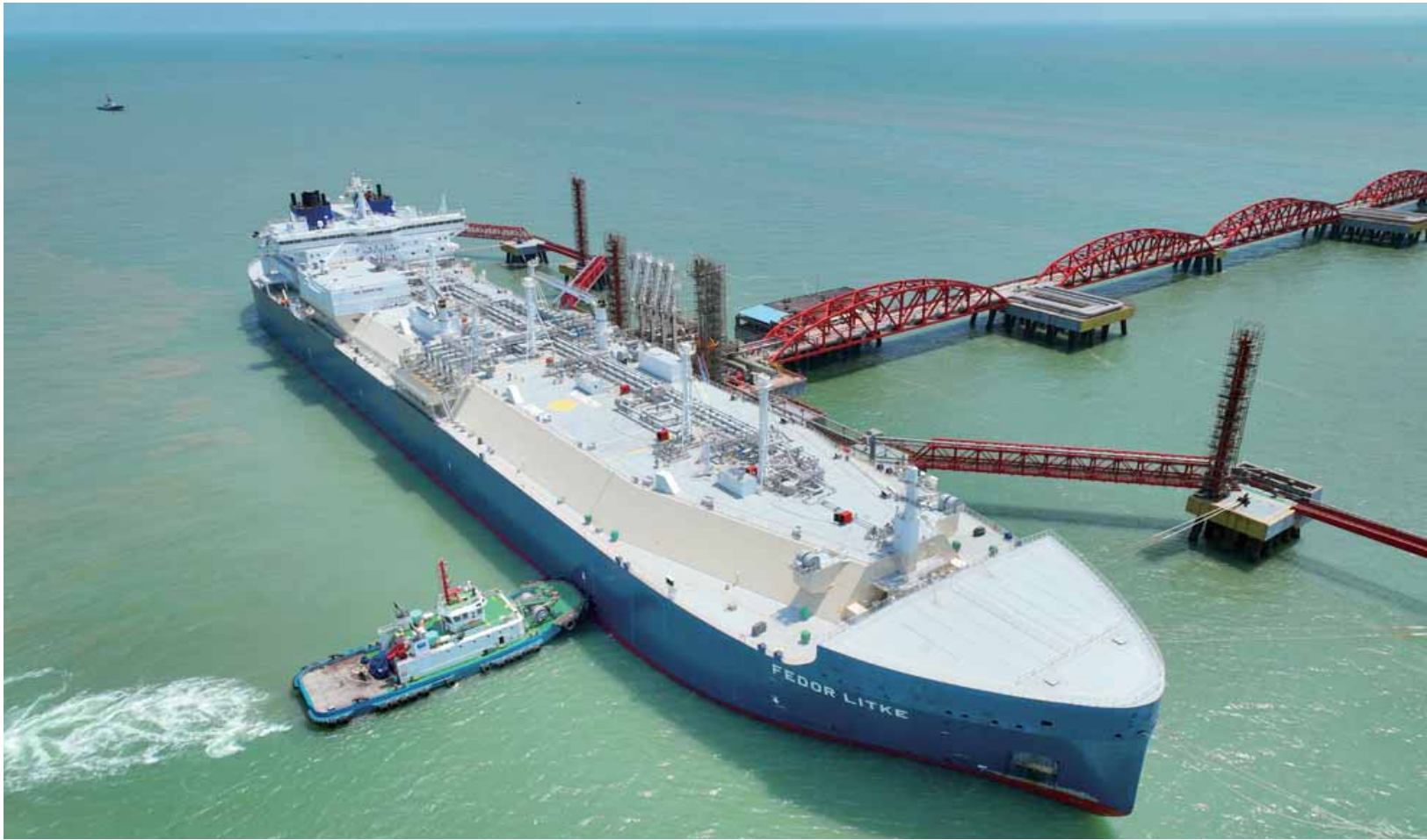
8 月 13 日，装载着 16.8 万立方米 LNG 的塞浦路斯籍“利特克”轮靠泊位于江苏省如东县洋口港的中石油江苏 LNG 接收站码头，这是今年江苏 LNG 接收站接卸的第 43 船进口 LNG。据悉，自 2011 年 5 月投产至今，接收站已经接卸了来自俄罗斯、秘鲁、卡塔尔等世界各地 25 个国家和地区的 LNG 船 630 艘，其中 70%为“一带一路”沿线国家。
