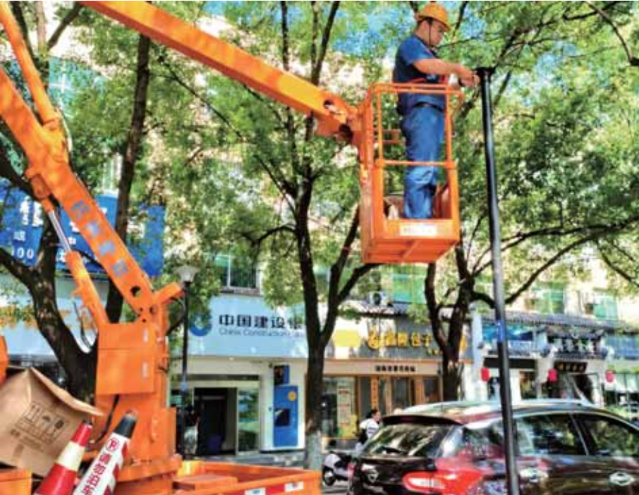
检修人员在高空作业车上维修受损灯具。
