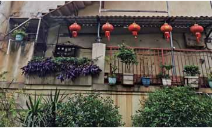
老居民房外墙“穿衣戴帽”。
