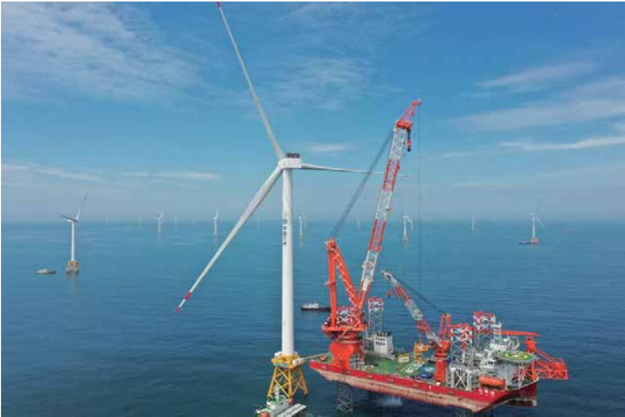
图为6月28日拍摄的全球首台16兆瓦海上风电机组吊装现场（无人机照片）。
