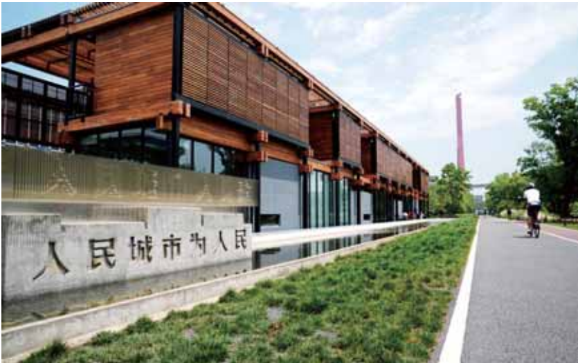
“祥泰木行”旧址重修建设为杨浦滨江人民城市建设规划展示馆（2021年5月15日摄）。 ■新华社发
