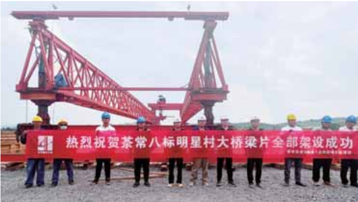
茶常高速明星村大桥顺利实现全幅贯通庆祝现场。
