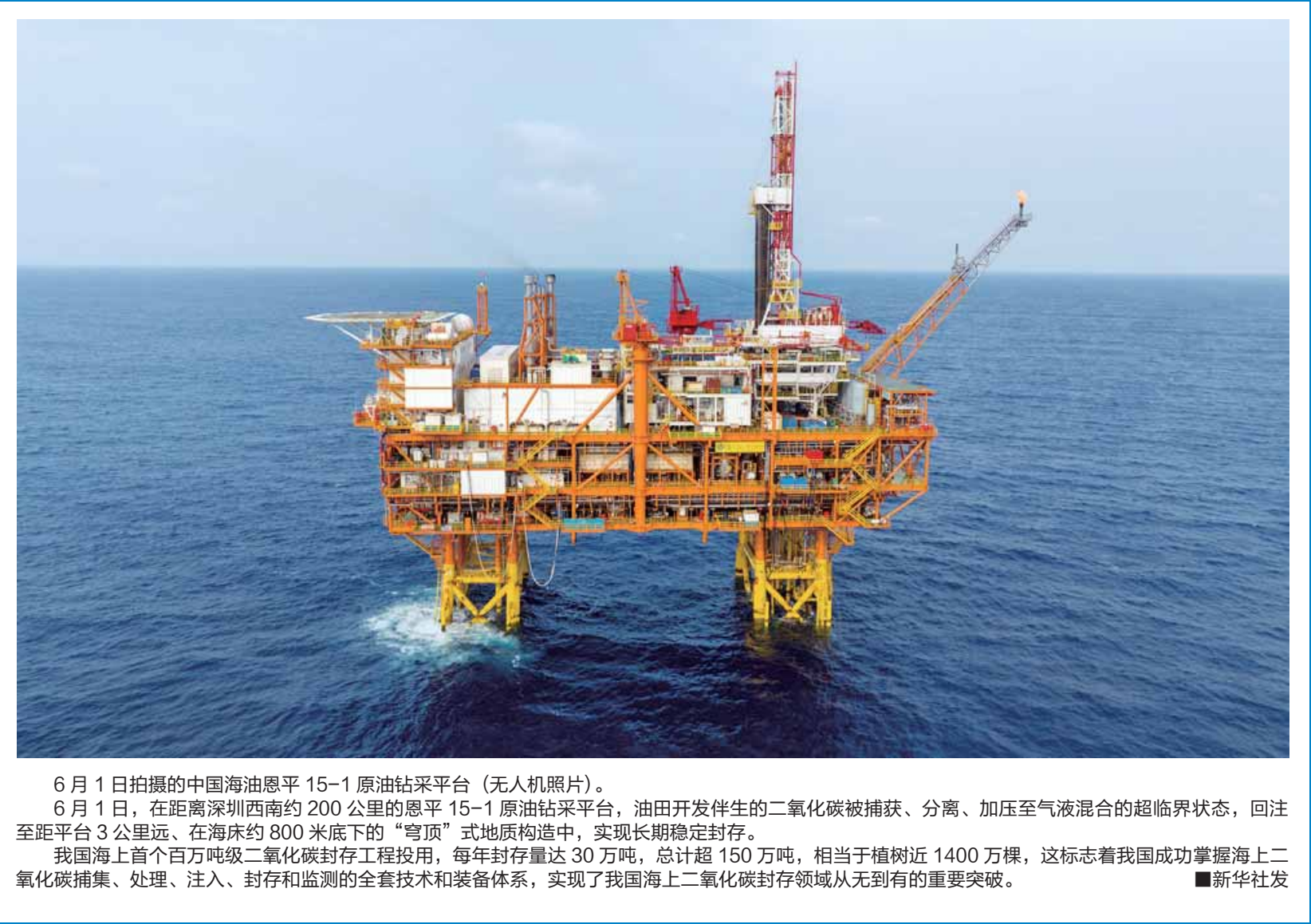
6月1日拍摄的中国海油恩平15-1原油钻采平台（无人机照片）。6月1日，在距离深圳西南约200公里的恩平15-1原油钻采平台，油田开发伴生的二氧化碳被捕获、分离、加压至气液混合的超临界状态，回注至距平台3公里远、在海床约800米底下的“穹顶”式地质构造中，实现长期稳定封存。我国海上首个百万吨级二氧化碳封存工程投用，每年封存量达30万吨，总计超150万吨，相当于植树近1400万棵，这标志着我国成功掌握海上二氧化碳捕集、处理、注入、封存和监测的全套技术和装备体系，实现了我国海上二氧化碳封存领域从无到有的重要突破。
