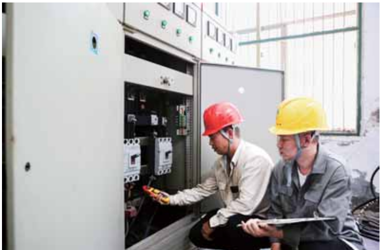
运维人员摸排设备隐患缺陷。
