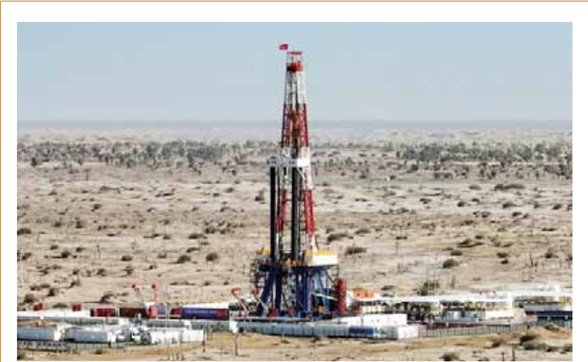
图为5月30日拍摄的“深地塔科1井”（无人机照片）。5月30日，我国首个万米深地科探井在新疆塔里木盆地正式开钻，这口井被命名为“深地塔科1井”，预计钻探深度11100米，位于塔克拉玛干沙漠腹地。开钻前，地面架设起约20层楼高的钢铁塔架，稳稳矗立在流沙之上。开钻后，重达2000多吨的钻头、钻杆、套管等将深入地下，穿透白垩系等10多个地层，成为探索地球深部的“望远镜”。据专家介绍，开钻万米深井，是探索地球未知领域、拓展人类认识边界的一次大胆尝试。 ■新华社发
