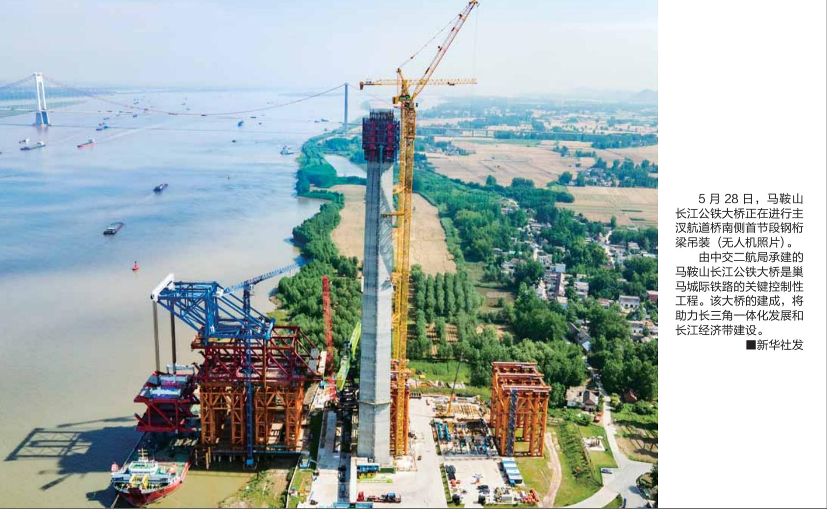
5月28日，马鞍山长江公铁大桥正在进行主汊航道桥南侧首节段钢桁梁吊装（无人机照片）。
