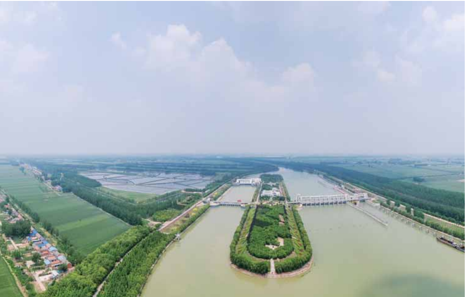
这是位于江苏省泗洪县的南水北调东线一期工程泗洪站枢纽（无人机全景照片，5月12日摄）。5月14日，中国南水北调集团有限公司宣布，南水北调东、中线一期工程目前累计向北方调水超过620亿立方米，其中实施生态补水近100亿立方米，发挥了显著的经济、社会、生态等效益。
