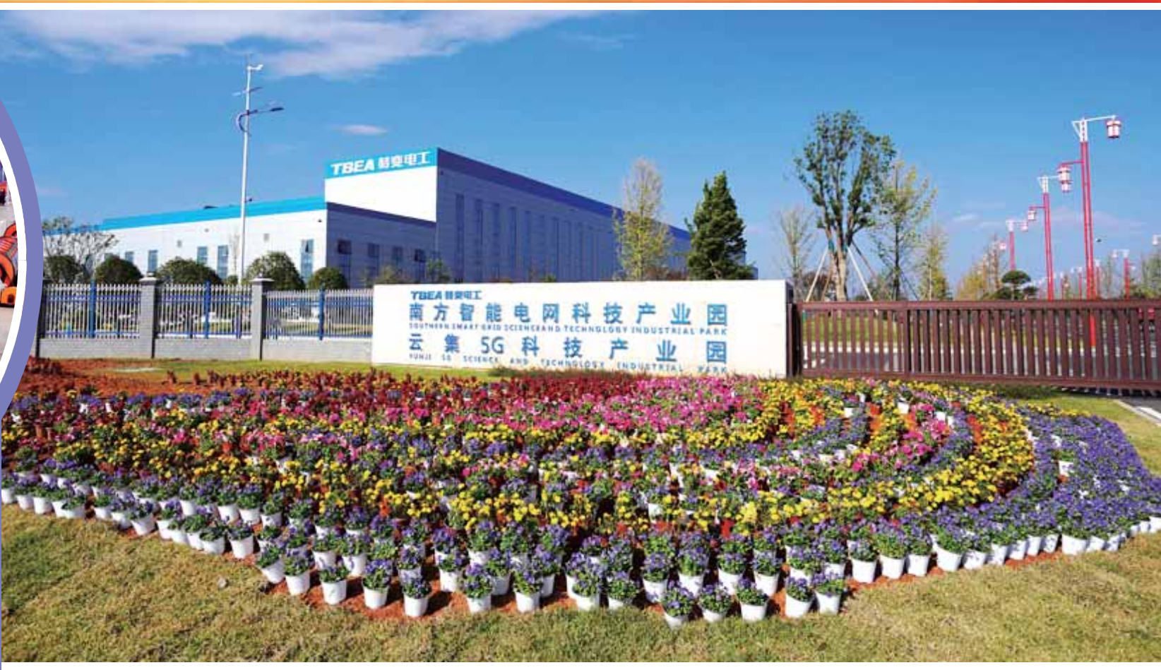
全国首个 5G 输变电产业园。 ■衡变公司供图
