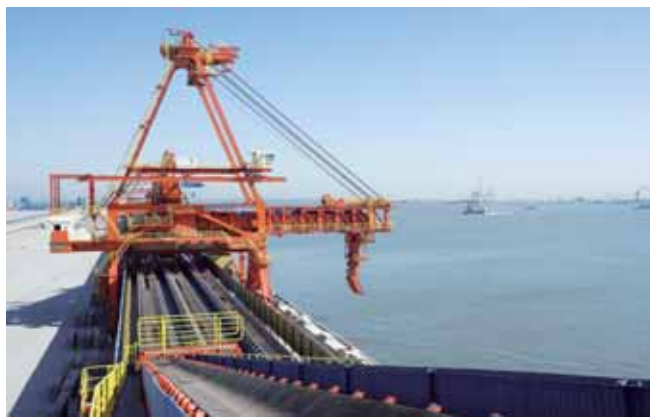
衡阳运机承建的福建罗源湾码头散状物料输送系统。 ■王 玫 摄
