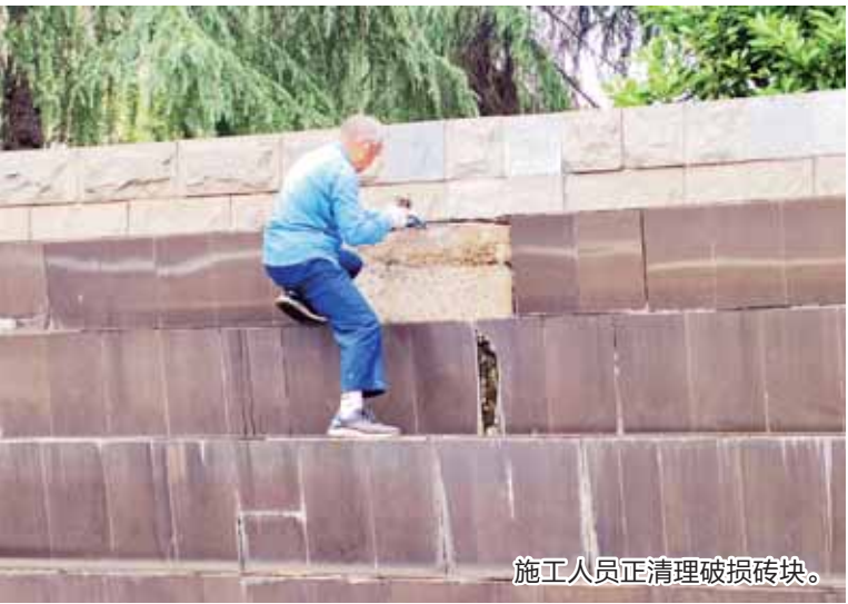
施工人员正清理破损砖块。
