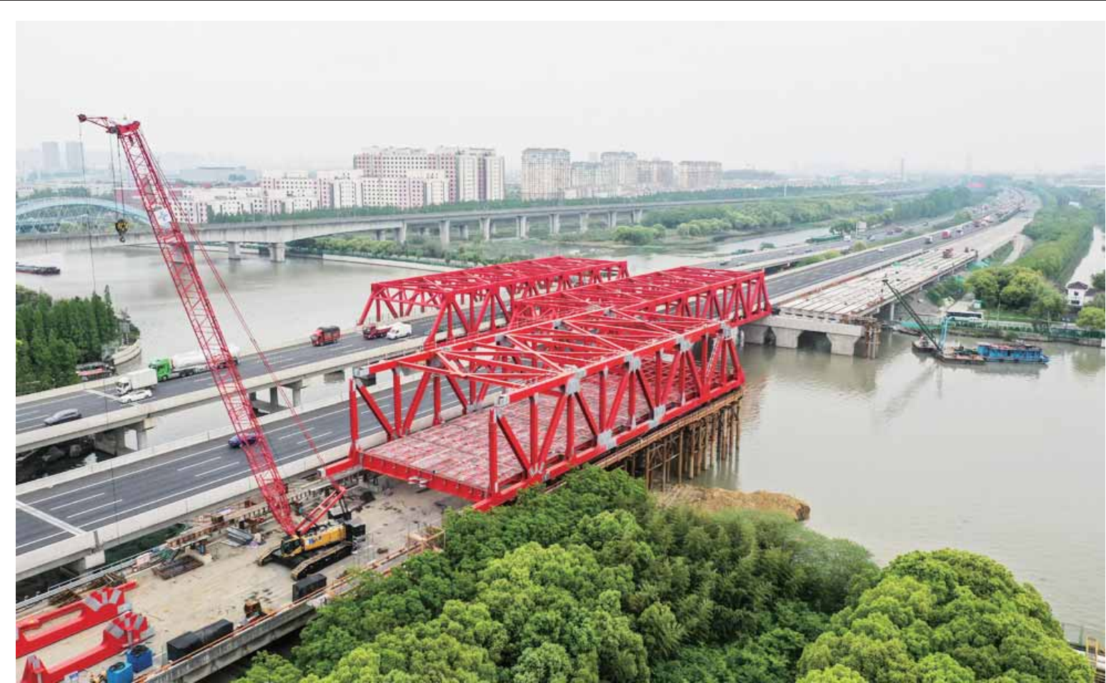
4 月 25 日拍摄的沪宁高速公路青阳港大桥南半幅钢桁梁施工现场（无人机照片）。当日，由中铁二十局承建的沪宁高速公路青阳港大桥改造升级工程南半幅钢桁梁首次顶推顺利完成，为早日建成通车奠定坚实基础。为确保改造升级期间高速公路正常通行，中铁二十局在大桥北侧新建一座保通桥。沪宁高速公路青阳港大桥改造升级工程是江苏省重点工程，项目建成后将极大提升青阳港水运通航能力。
