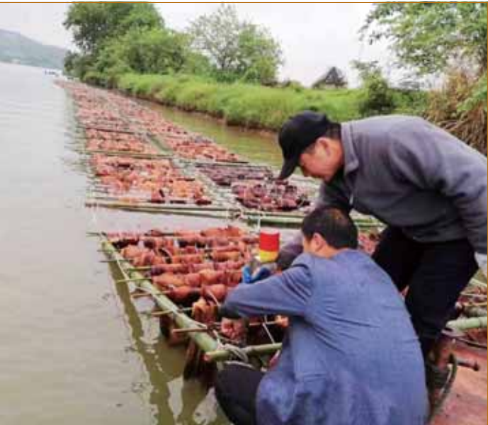
工作人员加紧安装太阳能警示灯。
