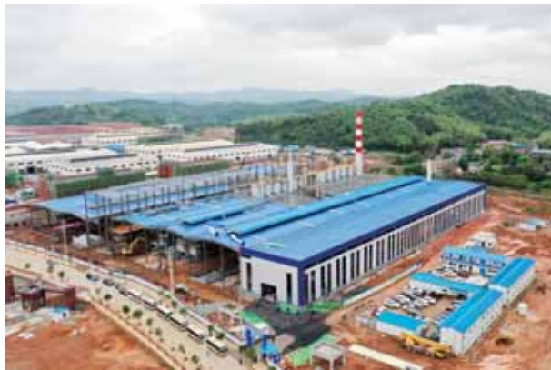
丰隆环保材料年处理8万吨危废综合利用项目。
