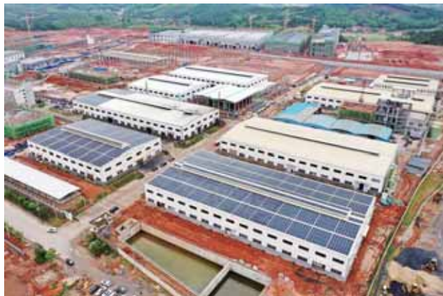
金凯循环废旧锂电池和含锂废料回收循环利用项目。
