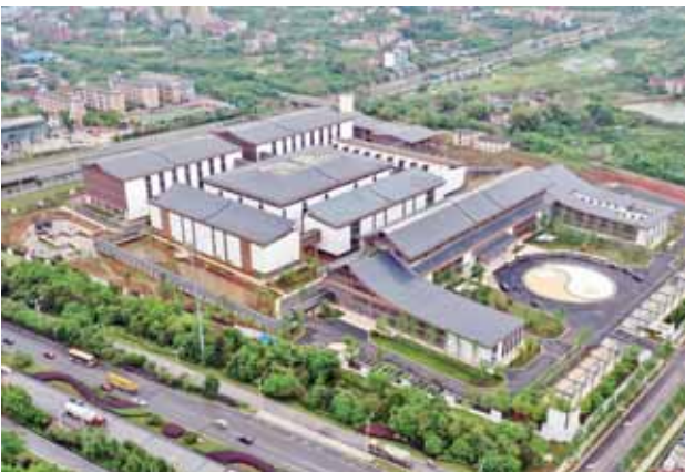
同祺生物科技园项目。
