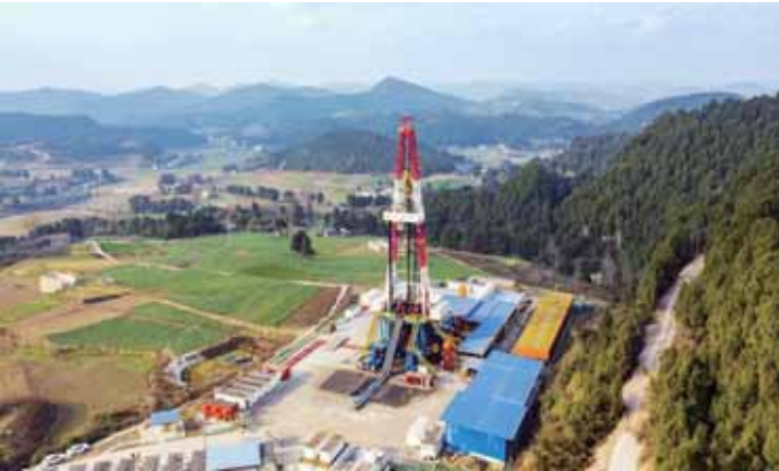
衡钢 9026 米亚洲最深直井。（产业链办供图）
