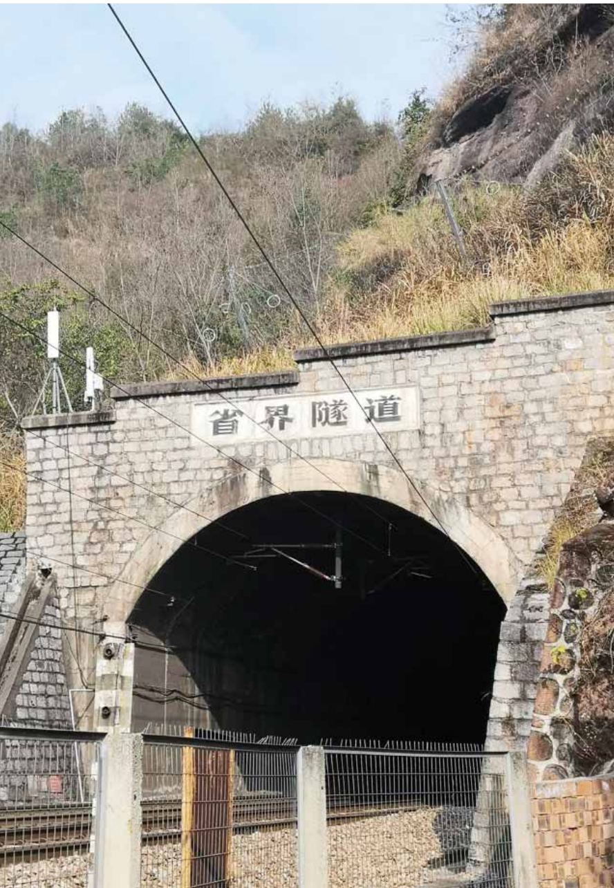
粤汉铁路白石渡的粤湘省界隧道。
