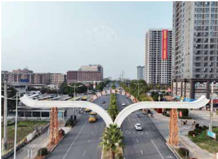
输变电工业小镇一角。
