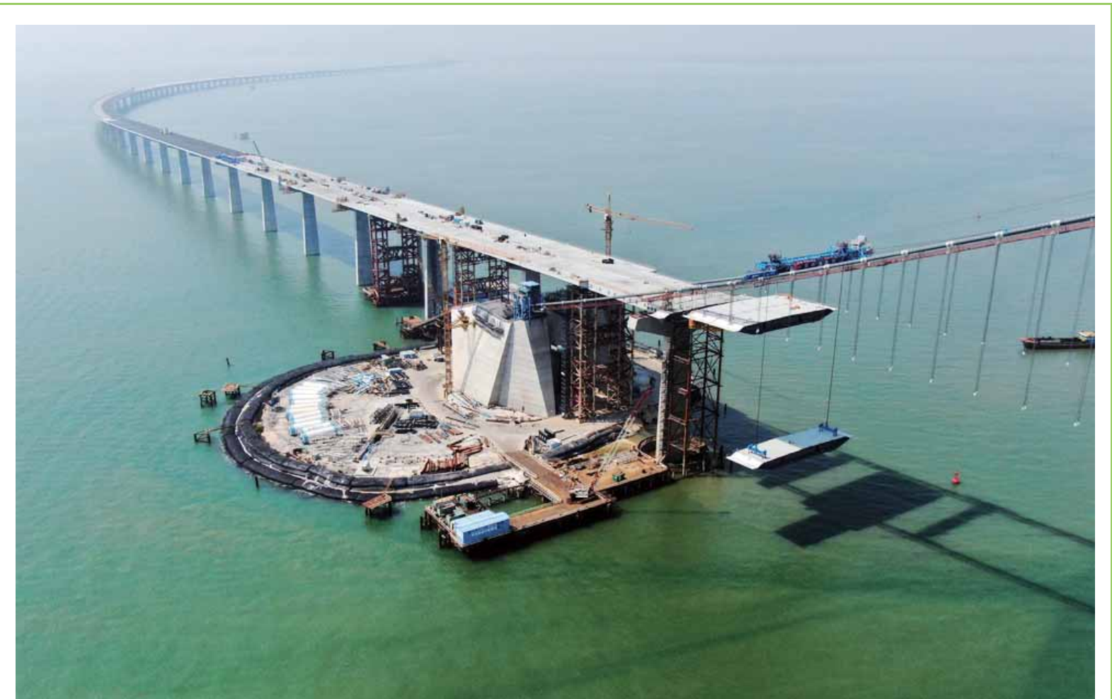
这是2月22日拍摄的正在吊装钢箱梁的深中通道伶仃洋大桥边跨（无人机照片）。目前，深中通道伶仃洋大桥有序推进钢箱梁吊装施工。伶仃洋大桥是深中通道的重要组成部分，主跨1666米，是世界上最大跨径的海上钢箱梁悬索桥。
