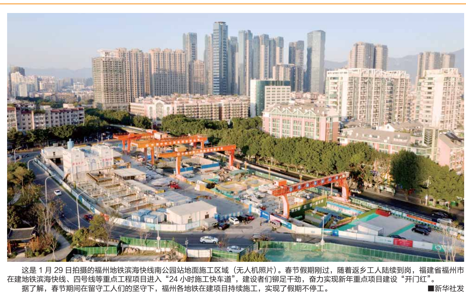
这是1月29日拍摄的福州地铁滨海快线南公园站地面施工区域（无人机照片）。春节假期刚过，随着返乡工人陆续到岗，福建省福州市在建地铁滨海快线、四号线等重点工程项目进入“24小时施工快车道”，建设者们铆足干劲，奋力实现新年重点项目建设“开门红”。据了解，春节期间在留守工人们的坚守下，福州各地铁在建项目持续施工，实现了假期不停工。
