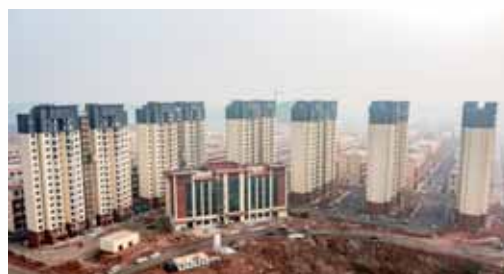
人才公寓正在进行精装修。
