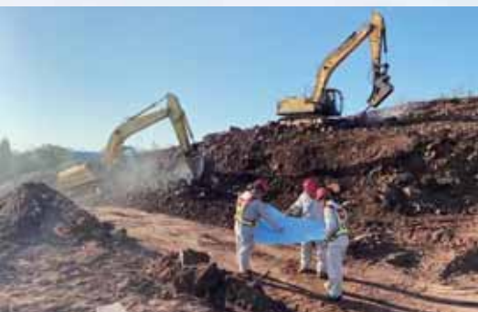
衡阳西500千伏变电站工程动土开工。
