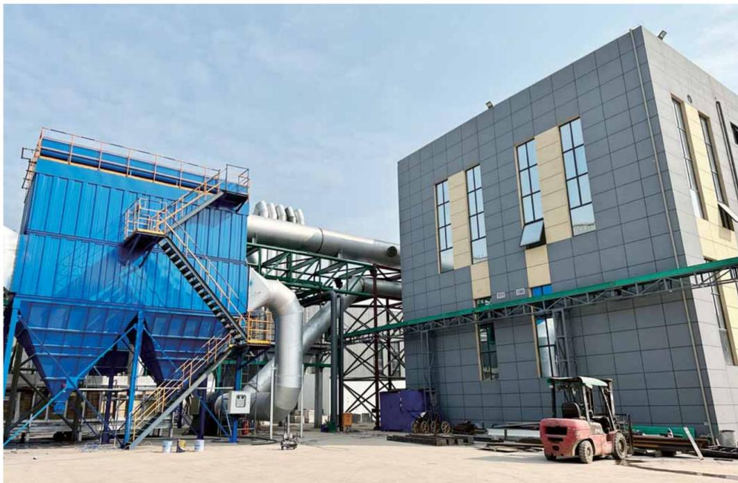
冶炼过程中，含有金属粉尘尾气通过管道进入除尘器过滤后，再进入脱硫脱硝系统处理，实现达标排放。
