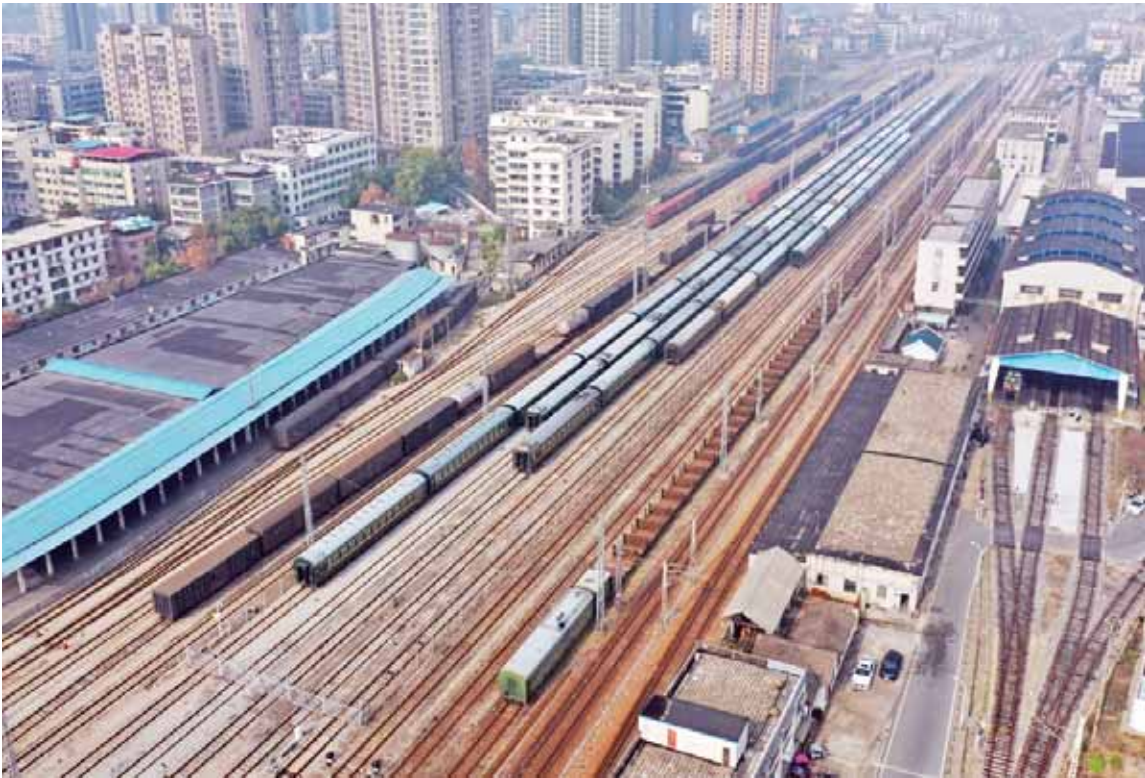
衡阳站北场客技库客车车体整装待发，为春运做准备。
