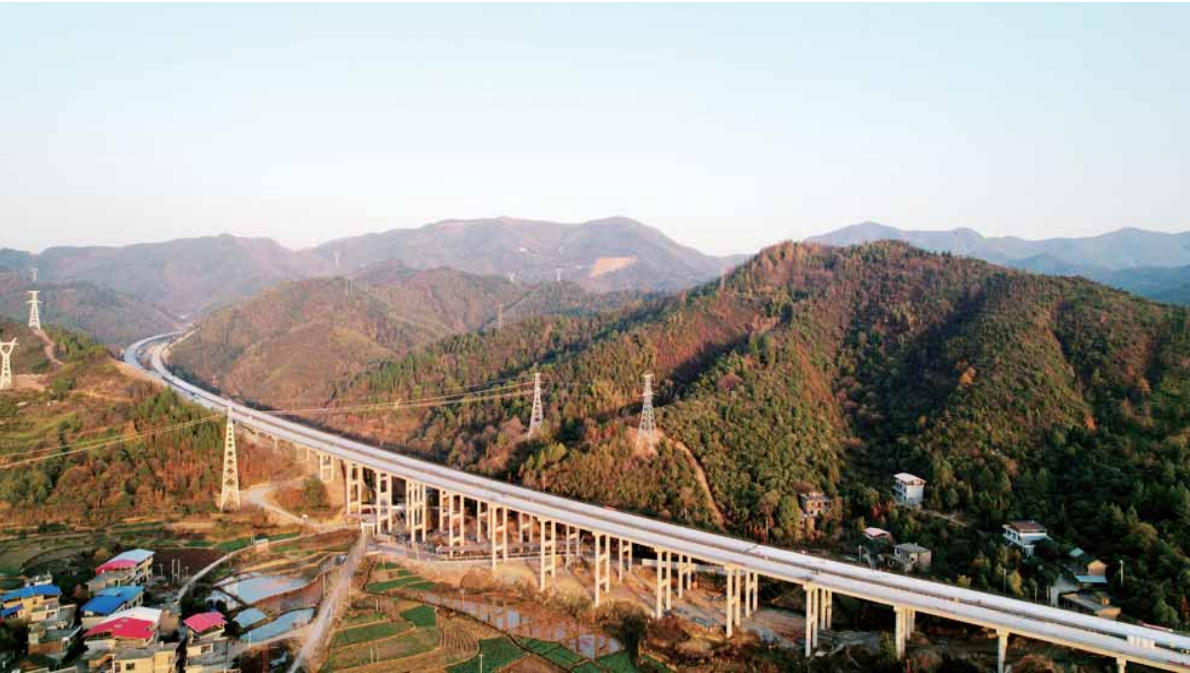
高家院大桥实现双幅贯通。
