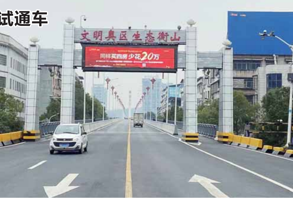
衡山湘江大桥维修改造工程已全面完成，开始试通车。
