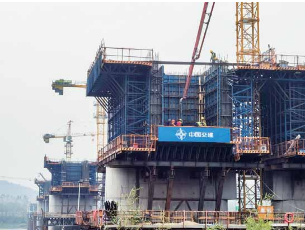
白南高速公路第三合同段董家潭湘江特大桥建设现场。
