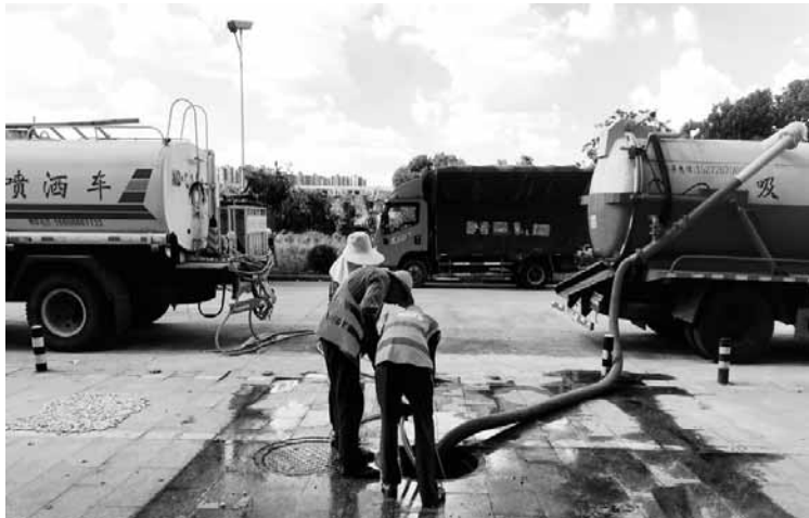
金龙小区化粪池清淤。
