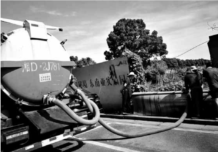
赵家冲路污水管改道及清淤。
