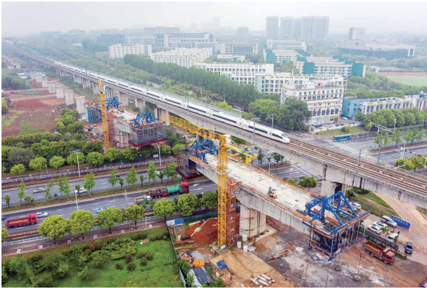
中铁四局四公司的工程人员在江苏南沿江城际铁路站前I标工程跨天元东路连续梁施工点施工作业。■新华社发
